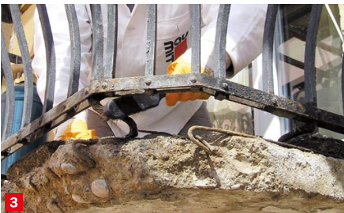
3 A sérült betont gondosan távolítsuk el és egészen addig folytassuk a munkát, amíg elérjük az ép részeket. Az acélbetétek és a beton közti tapadás megfelelőségét ellenőrizzük. A betonacélokat drótkéfével tisztítsuk mindaddig, amíg fényleni nem kezdenek.
