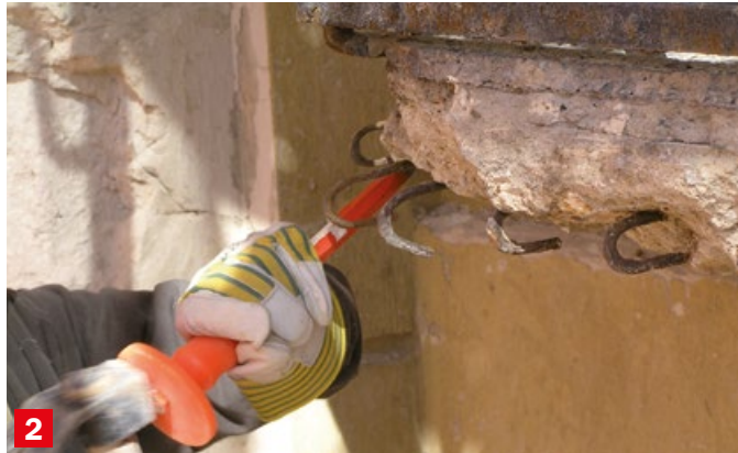
2 A sérült részek eltávolítása csiszolással, vésővel vagy kalapáccsal. Ügyeljünk arra, hogy a megfelelő állapotú betonban ne tegyünk kárt! Nagyobb felületek esetén alkalmazzunk homokfúvást.
