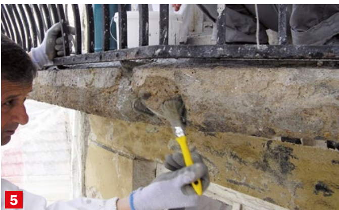
5 Az acélbetétekre a korrózióvédelmet biztosító Baumit BetoProtect betonacél-védőszert ecsettel hordjuk fel, 2 rétegben. A második réteg felvitele előtti várakozási idő 6 óra.
