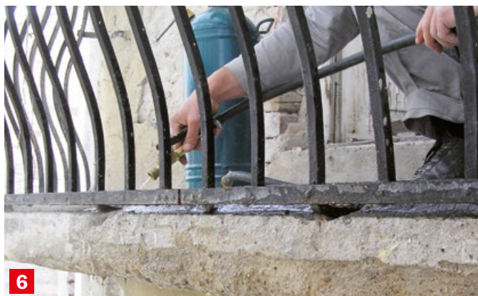
6 A Baumit BetoFill javítóhabarcs felhordása előtti napon még egyszer tisztítsuk le vízzel a felületet. Addig várjunk, ameddig a vízfilm már mindenhol eltűnt.
