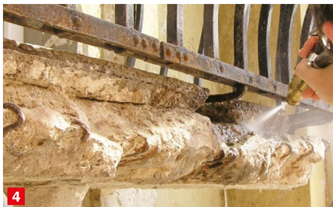
4 24 órával a Baumit BetoFill javítóhabarcs felhordása előtt az alapfelületet nagynyomású vízszugárral mossuk át, ezzel biztosíthatjuk a majdani megfelelő tapadást.
